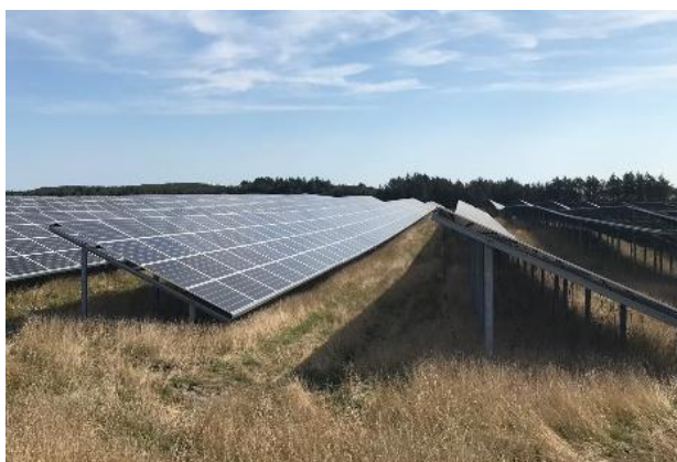
Solcellepaneler på faste paneler.
