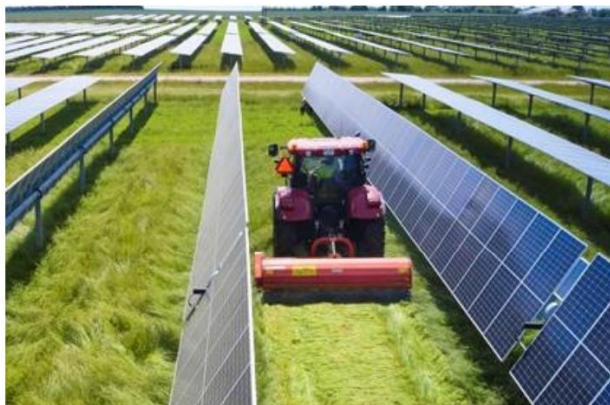
Solcellepaneler med tracker system.
